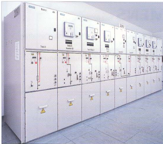
Bild 1: Schaltanlage NXPlus C
