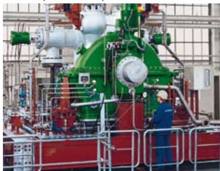
SST-600 (hasta 100 MW)
