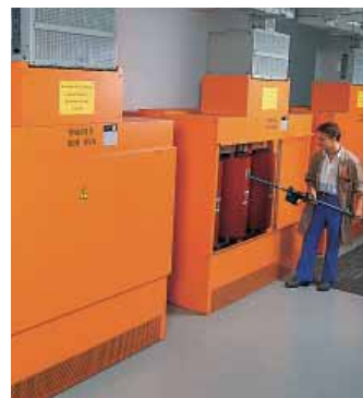
Enveloppe de protection standards GEAFOL par ex. pour le degré de protection IP 20. Autres variantes d'enveloppes disponibles sur demande.
