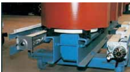
Augmentation de puissance de jusqu'à 50 % par adjonction de ventilateurs à flux transversal
