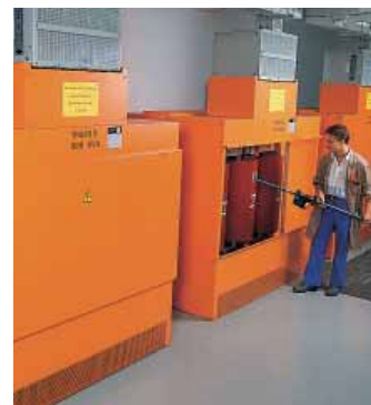
GEAFOL-Standardschutzgehäuse: z. B. nach Schutzart IP 20; auf Wunsch modifizierte Gehäusevarianten
