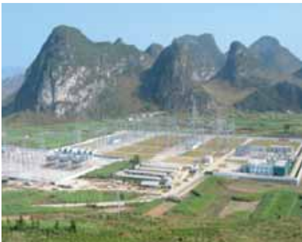
Turnkey-Anlage von Siemens zur Stabilisierung der Energieübertragung in Süd-China, 2004
