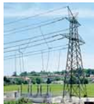
Einbindung der GIL ins Freileitungsnetz
