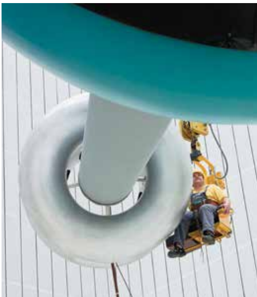
Für die Prüfung wird der Transformator vollständig aufgebaut und angeschlossen
