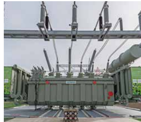
420-kV-Netztransformator mit natürlichem Ester
