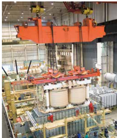
Der Aktivteil wird in den Kessel eingefahren
